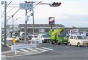
太子南交差点・右折レーン設置
